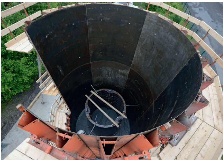
Fig. 10. Casing ring replicates the shaft wall. Bild 10. Schalung als Schachtwand. Photo/Foto: RAG
