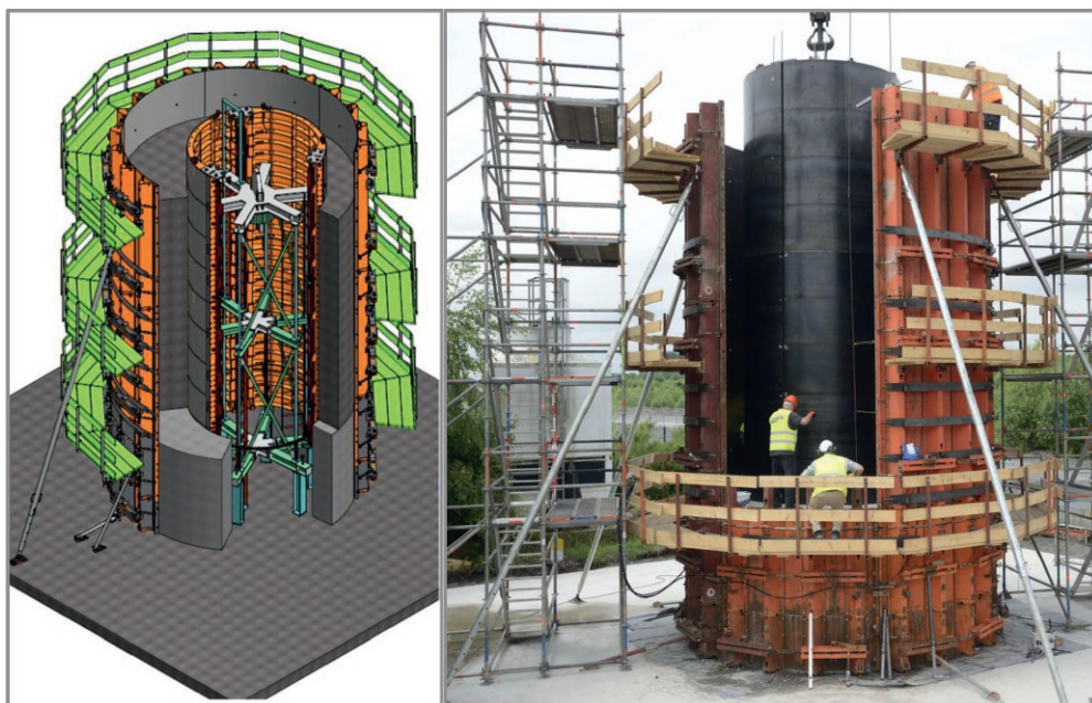
Fig. 13. Concreting test (left: planned scenario; right: reality). Bild 13 Betoniersuch (links: Planung; rechts: Realität). Source/Quelle: RAG
